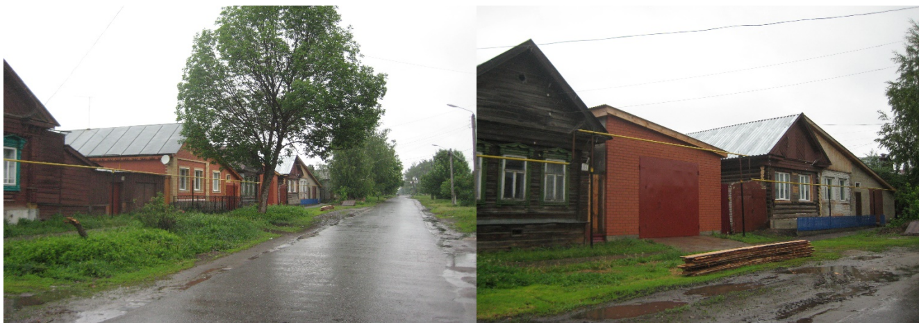
Рис. 1. Плотная застройка и отсутствие противопожарных разрывов между надворными постройками и жилыми домами (Алатырский район Чувашской Республики)
