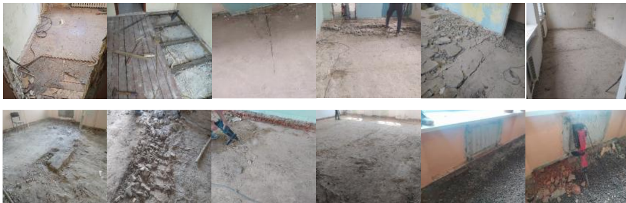
Рисунок №2. Ход производства демонтажных работ напольного покрытия Этап №2. Предварительная разметка высотных отметок и засыпка с предварительным разравниванием керамзитового слоя
