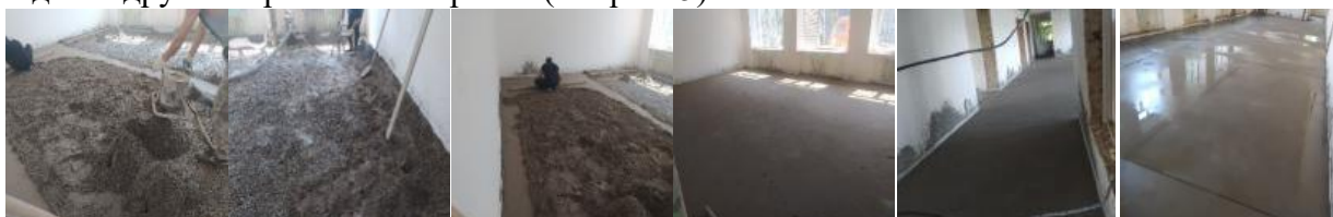
Рисунок №5. Ход производства работ по устройству цементно-песчаной стяжки
