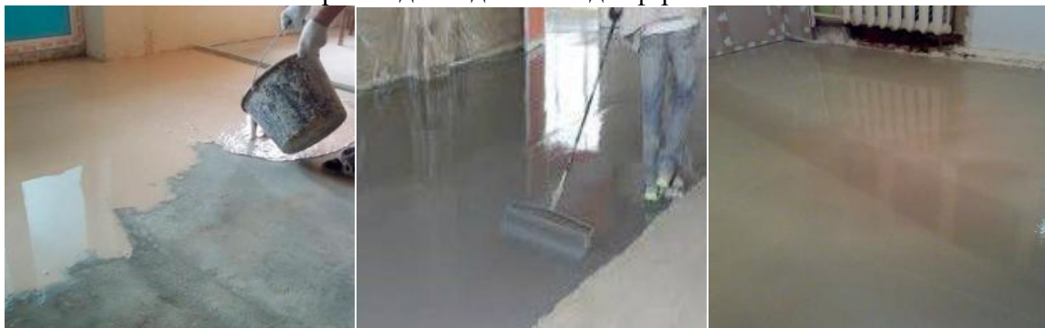
Рисунок №6. Ход производства работ по устройству наливного пола
