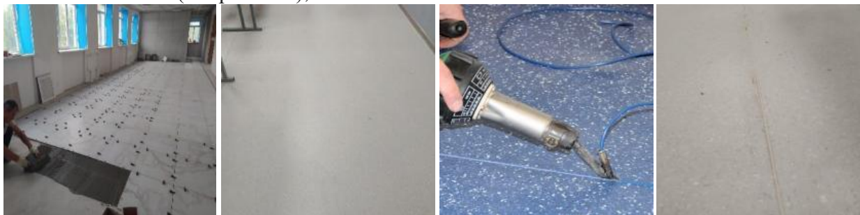
Рисунок №7. Ход производства работ по устройству финишного напольного покрытия
