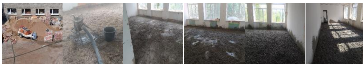
Рисунок №4. Ход производства работ по проливке цементным молочком керамзита
